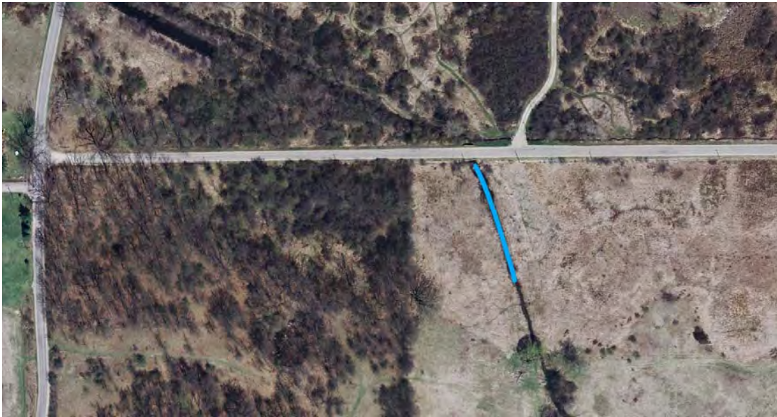
Site #10: York TWP Ditch CR 12
